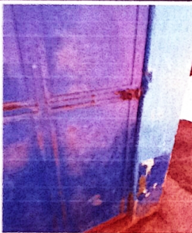
Foto 3: Reparación de puertas de baños
