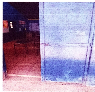
Foto 4: Susutitucion de puerta principal del aula de primero, segundo y tercero primaria
