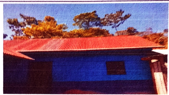
Foto 2: Sustitucion de laminas sobre el aula de cuarto, quinto y sexto primaria.
