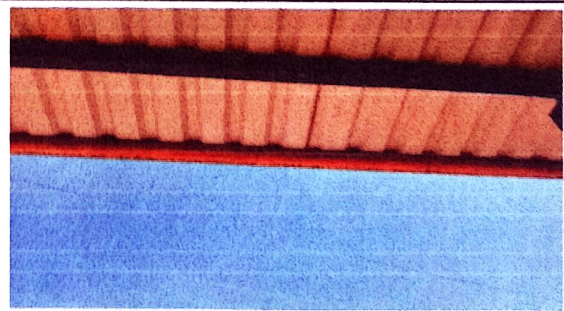
Foto 6 Sustitucion de canales pluviales
