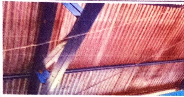
Foto 1: Reparación de cubierta de lamina a troqueladas
